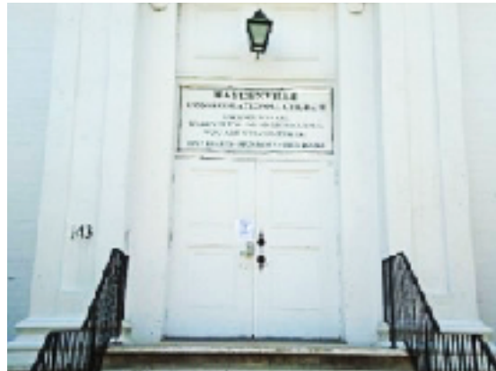
Our Front Door (Below)
